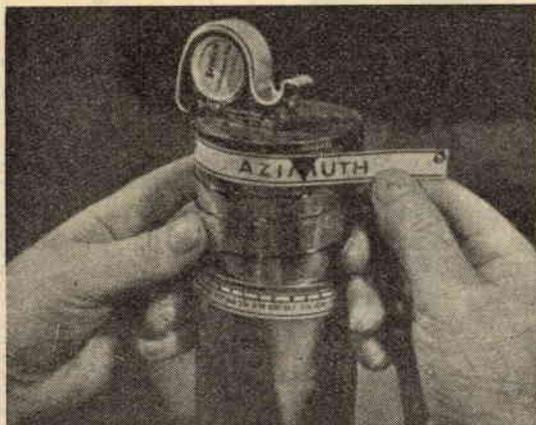
Le scale debbono essere protette con nastro alla cellulosa. Notate come è tracciato l'indice dell'azimuth.
